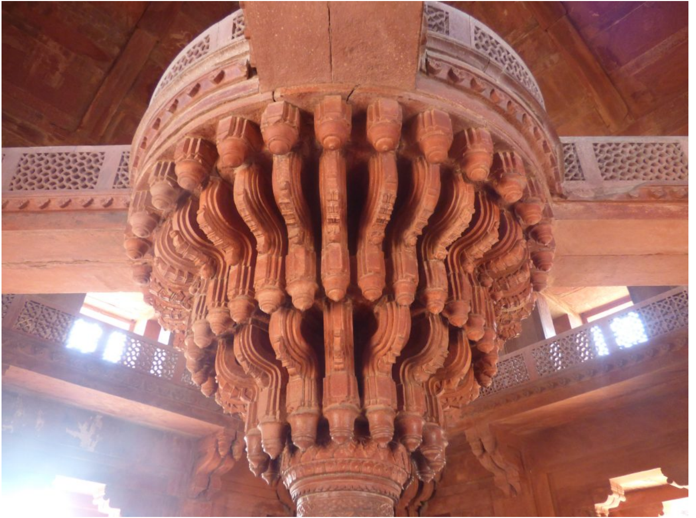
Das reich verzierte Kapitell der Säule bildet eine Plattform auf dem einst der Thron platziert war.
